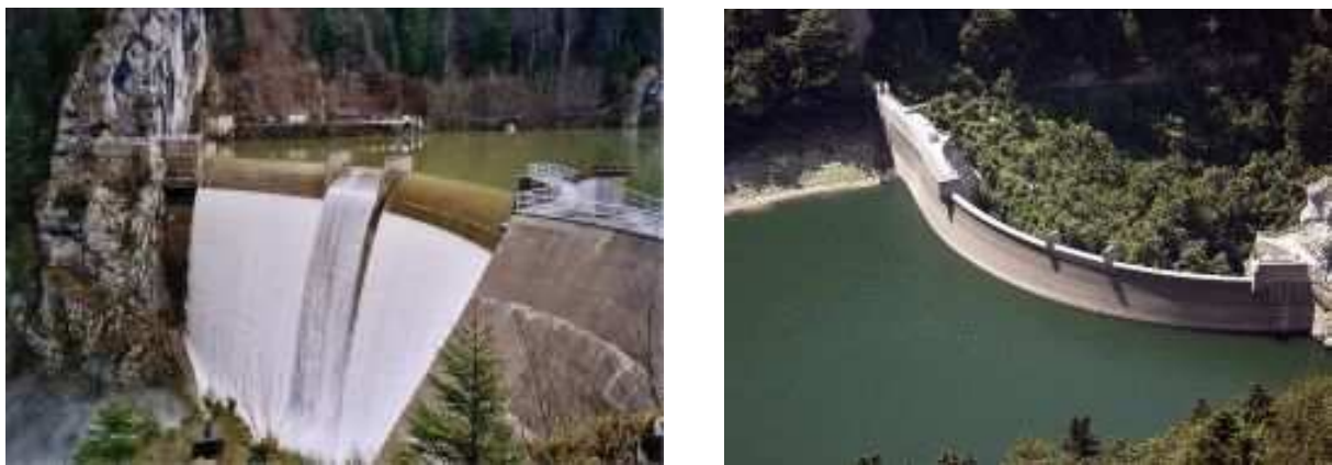
Figure 8 : photos du barrage voûte du Châtelot ( http://www.les-planchettes.ch/ )
